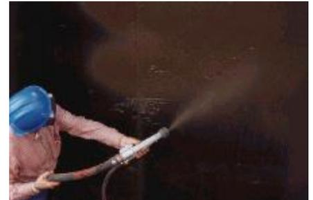
Sobre la imprimación seca, proyectar el mortero con máquina neumática de proyección (Tipo PFT N 2 V FU 400) o manualmente con “escobillón”, con un rendimiento aproximado de unos 4,0 kg/m<sup>2</sup> (en función de la rugosidad del soporte).
