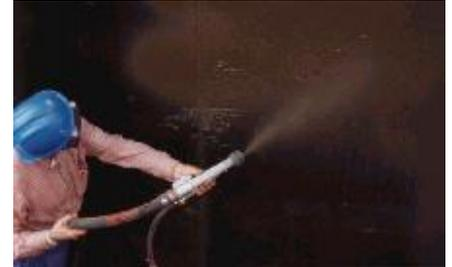
Sobre la imprimación seca, proyectar el mortero con máquina neumática de proyección (Tipo PFT N 2 V FU 400) o manualmente con “escobillón”, con un rendimiento aproximado de unos 4,0 kg/m<sup>2</sup> (en función de la rugosidad del soporte).
