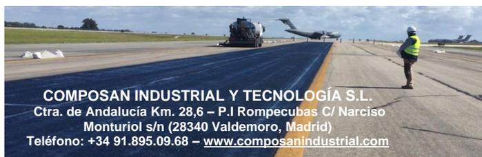
La dotación media de lechada seca por unidad de superficie y espesor (m<sup>2</sup> y cm) es de 1'5-2'0 kg (variable en función del contenido en huecos y del porcentaje de relleno de huecos).
